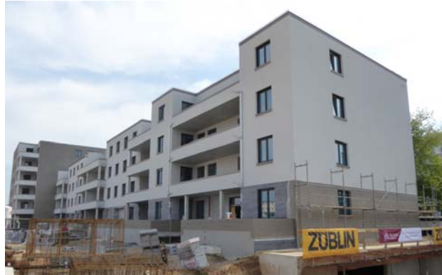
Das Haus 6 der PEGASUS-Residenz, eines der größten Häuser, wird Ende des Jahres fertiggestellt. Fotos (5) SachsenGAST
